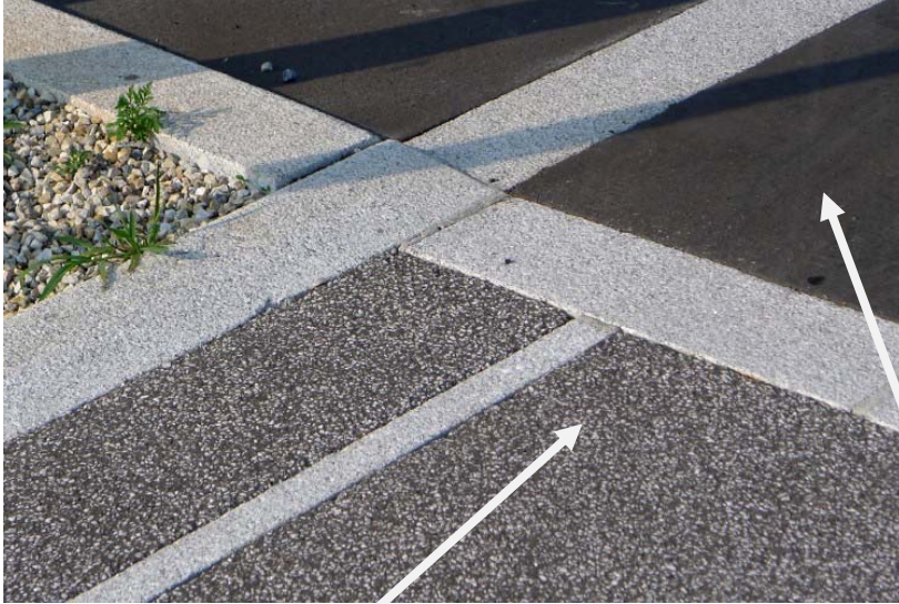
Enrobé grenaillé (traitement mécanique)
